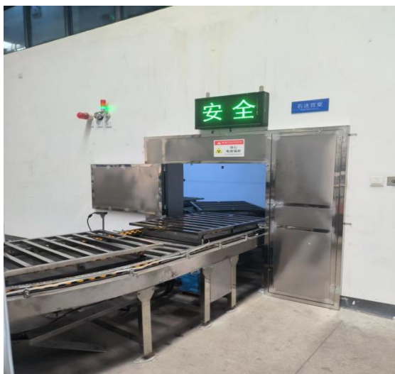
辐照室入口警示标识
