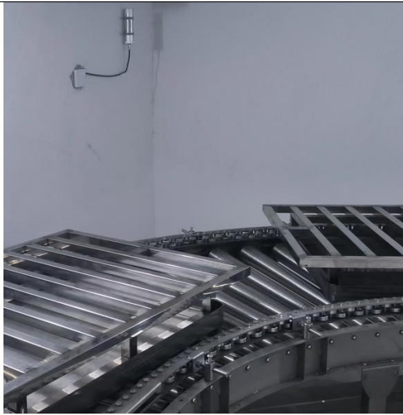
辐照室固定剂量探头
